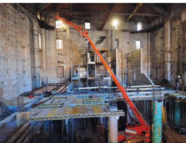
Монтаж металлоконструкций
